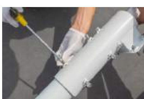
8. Inserte el poste de luz en el enchufe de conexión y fíjelo con tornillos
